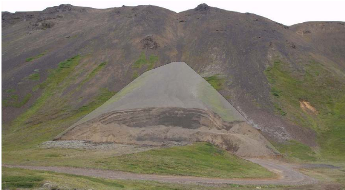
Mynd 5.2.10. Náma ÞRN-1, áætlað áhrifasvæði við frágang námu ÞRN-1. Nauðsynlegt er að mati ÓBS [13] að ýta efninu niður og jafna fláa. Hann telur að þá jafni svæðið sig á nokkrum árum. Hægt er að nota efnið sem til fellur vegna framkvæmda að Þeistareykjum. (Ljósmynd: ÓBS [13].)
